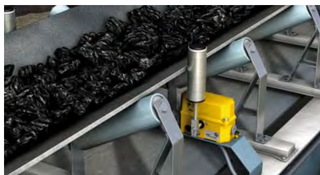
Монтаж тросовых выключателей и выключателей схода ремня
