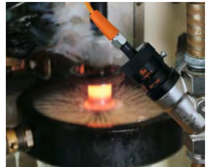
Мехатронный датчик потока в контуре охлаждения идукционной электропечи.
